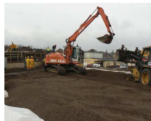
Uzyskano odciążenie organicznego podłoża oraz zlikwidowano parcie poziome na przyczółek dzięki warstwie 900 m 3 keramzytu ułożonego w nasypie drogowym - Wolsztyn 2007
